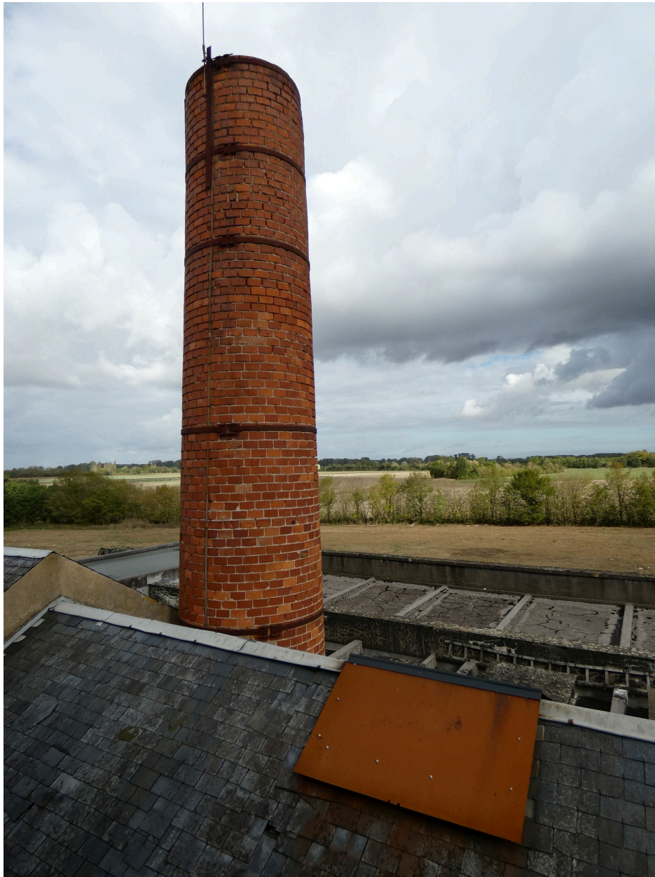
La cheminée en brique au-dessus du toit de la chaufferie, vue depuis le sud-est.
