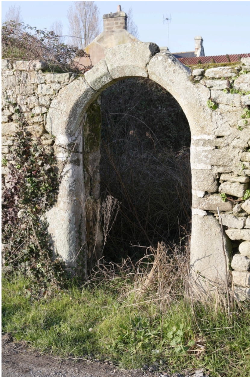
Détail de la porte d'entrée.
