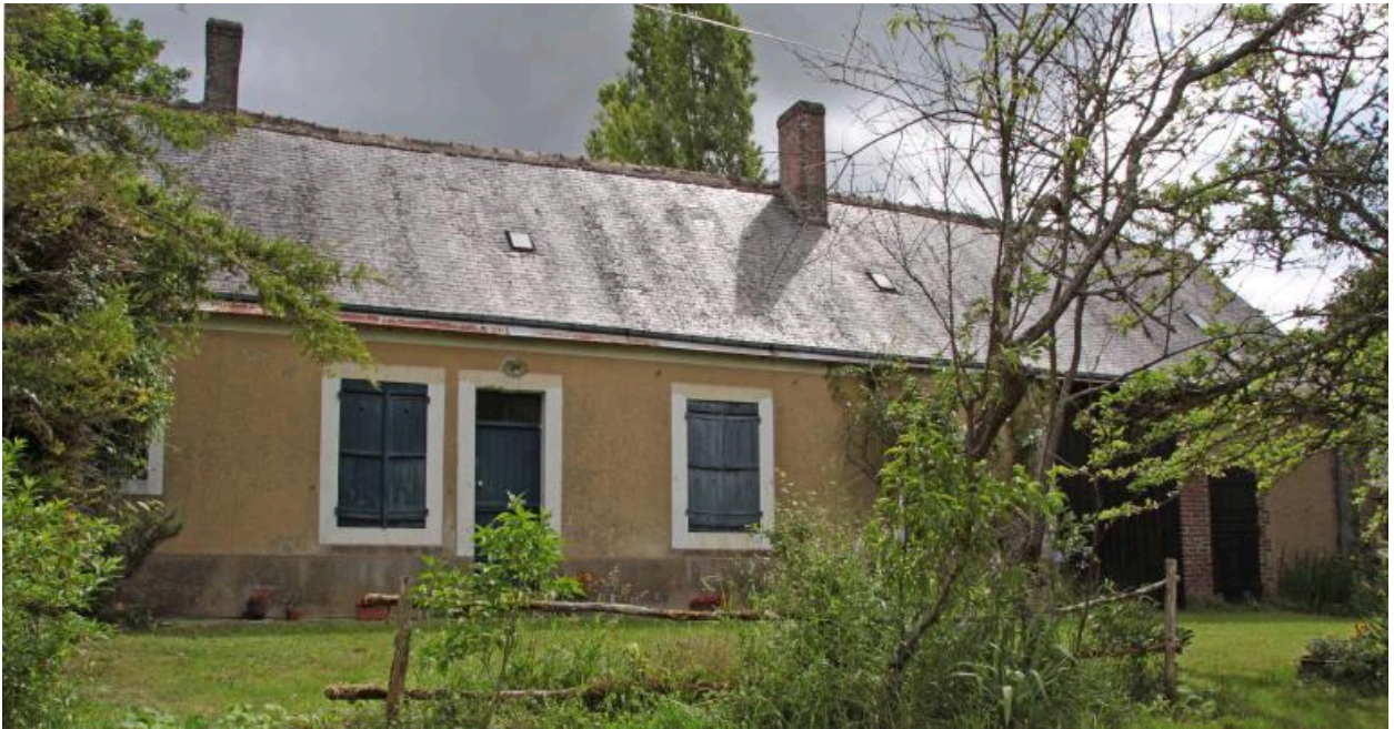
Vue d'ensemble prise depuis le sud.
