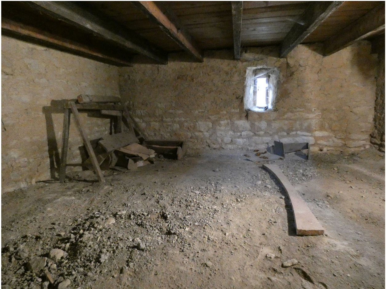
Le soubassement sous la sacristie sud-est.
