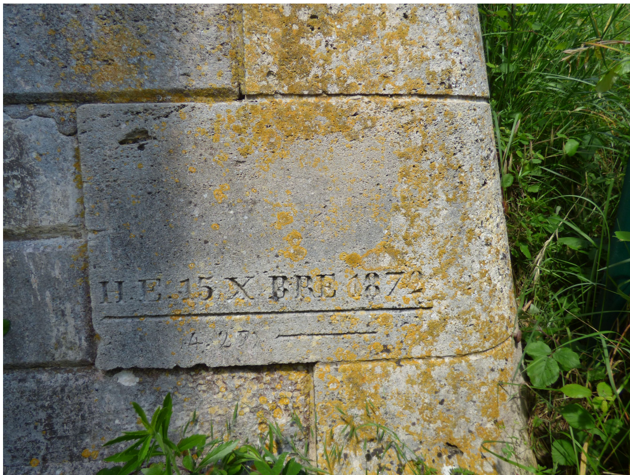
Repère de crue indiquant le niveau des hautes eaux atteint le 15 décembre 1872, sur la pile du pont côté rive droite.
