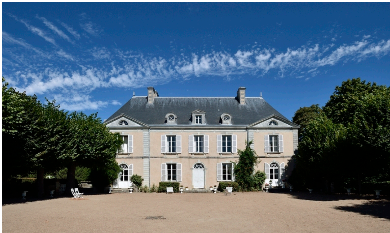
Vue de la façade sud.
