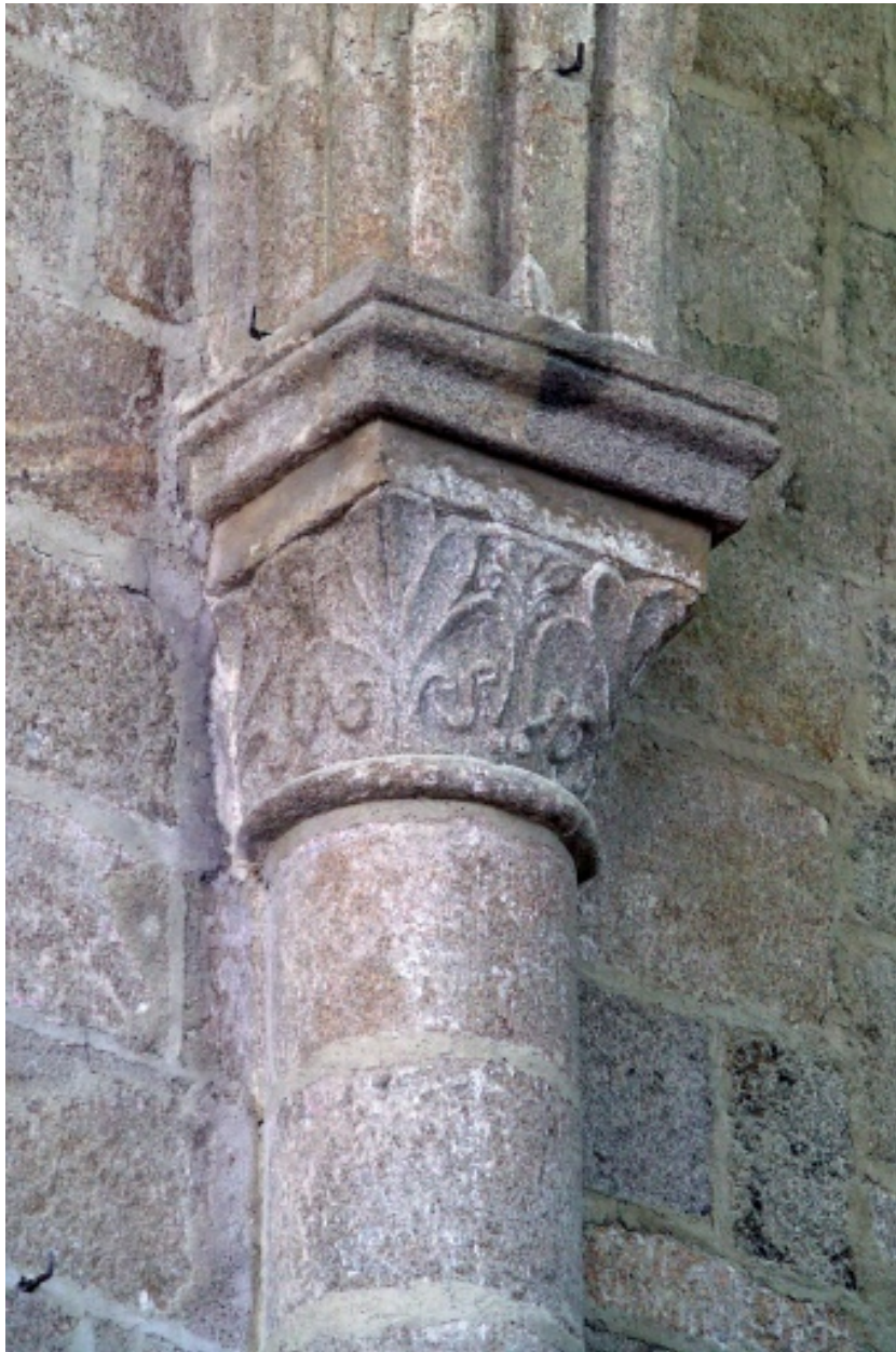
Détail d'un chapiteau du chœur.
