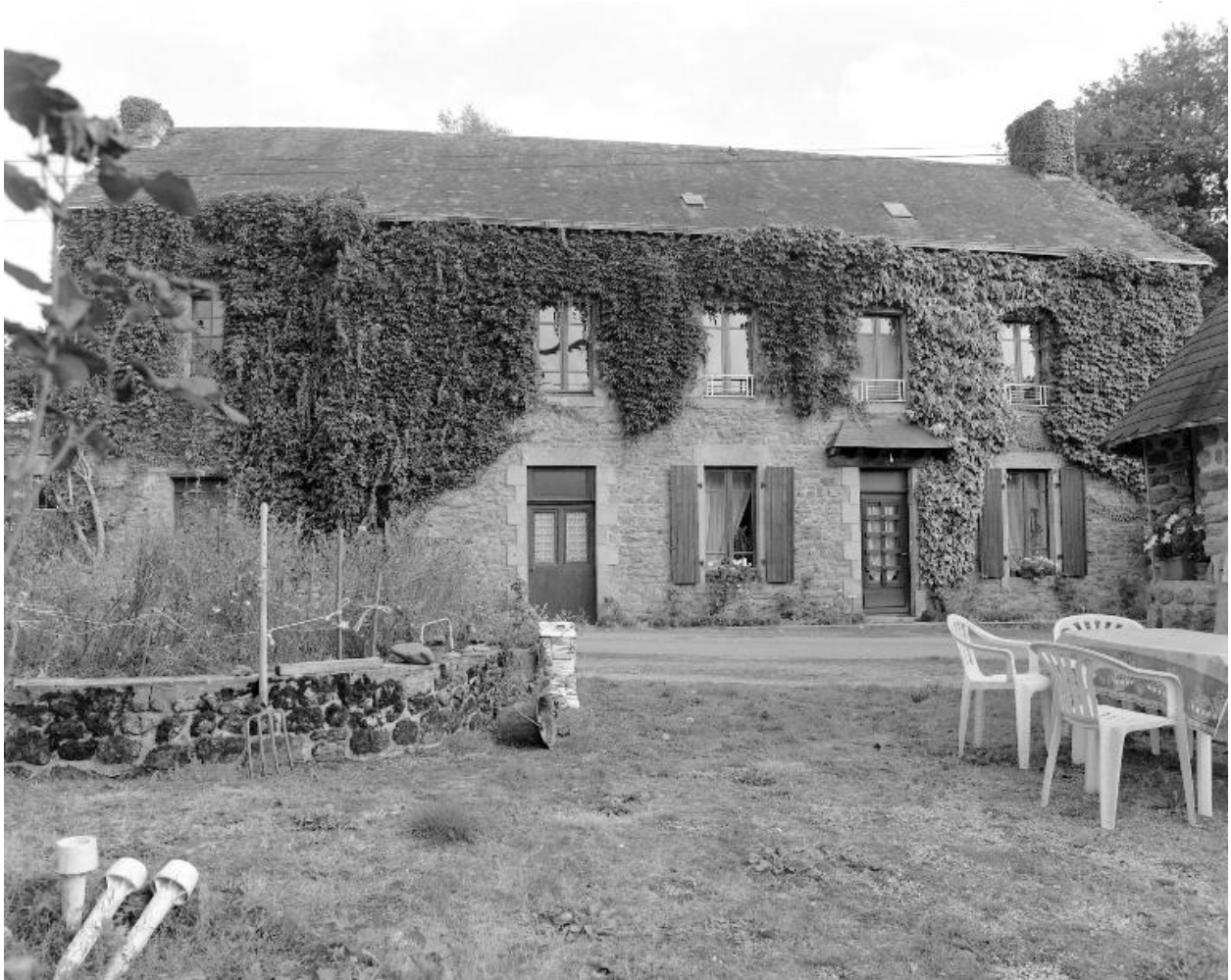
L'ancienne maison de meunier : façade antérieure.
