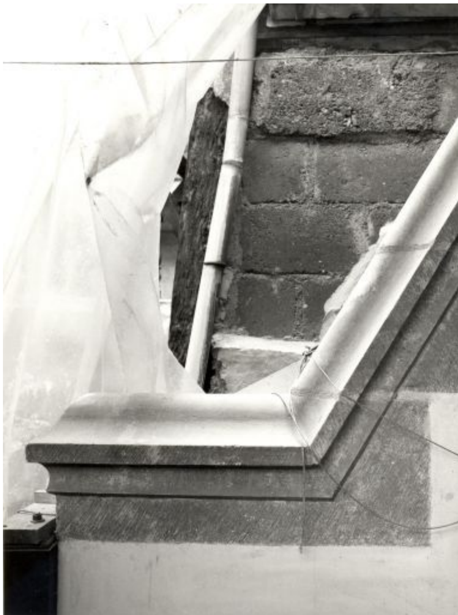
Détail du pignon gauche du corps antérieur (versant postérieur, départ)
