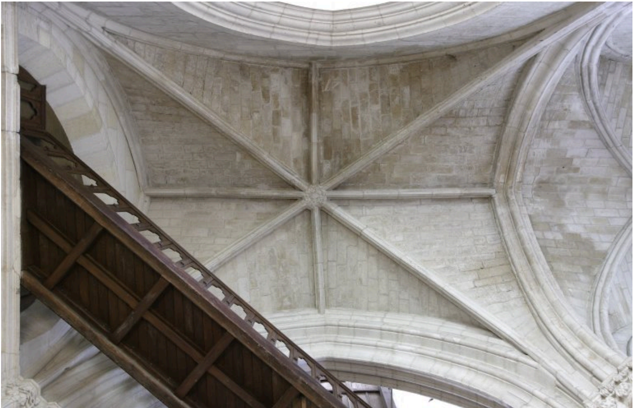
Bas-côté sud de la nef : voûte de la première travée.
