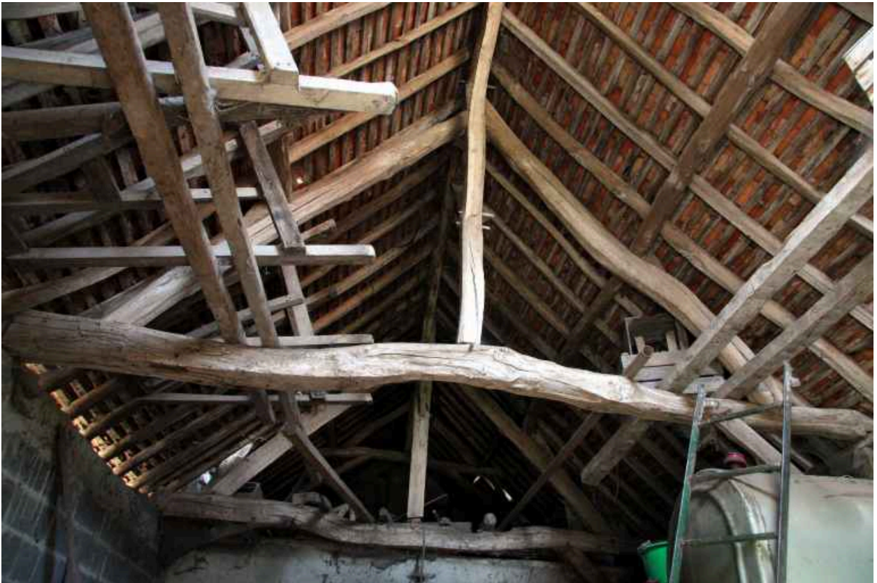
Ferme n°1, le hangar : charpente.
