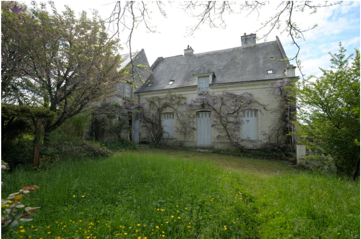
Façade nord, remaniée au XIXe siècle.
