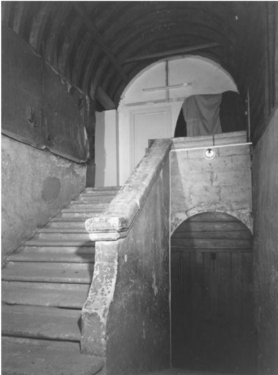
Pavillon sud-ouest de l'abbaye, escalier de service : dernière volée.
