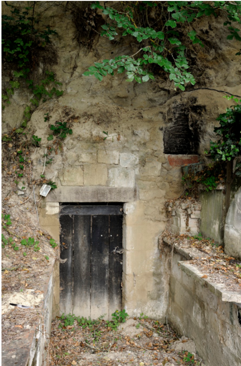
Abri troglodytique (cave à cheminée du XIXe siècle) de la parcelle F 954 (cadastre 2011) : porte, cheminée.
