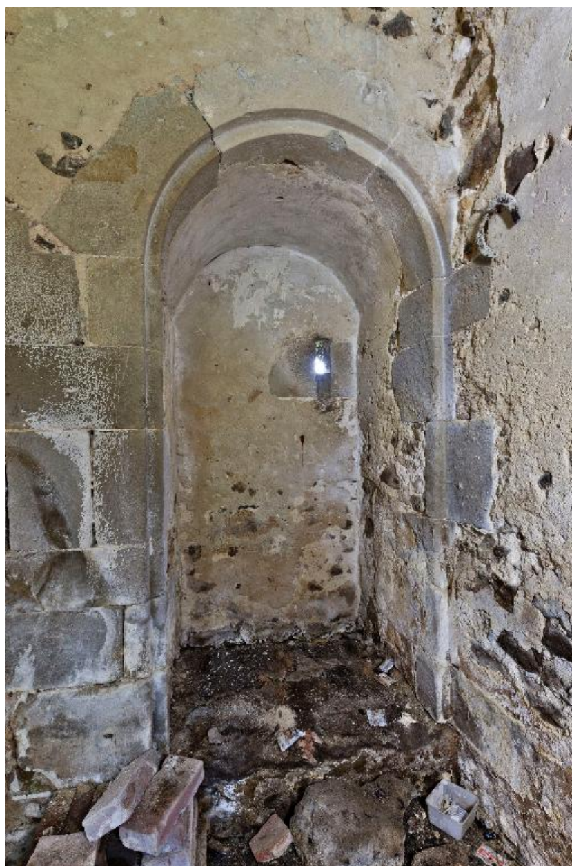
Arcade et meurtrière vers le sud, à droite de la cheminée.
