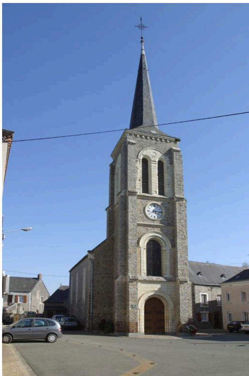
La tour-clocher et l'élévation nord depuis le nord-ouest.
