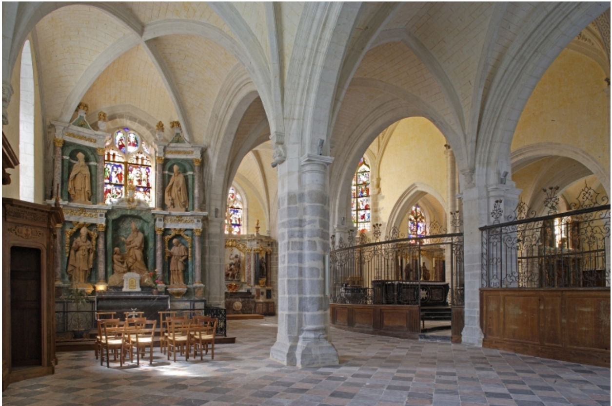
Choeur, collatéraux gauche après restauration : vue d'ensemble vers l'abside.
