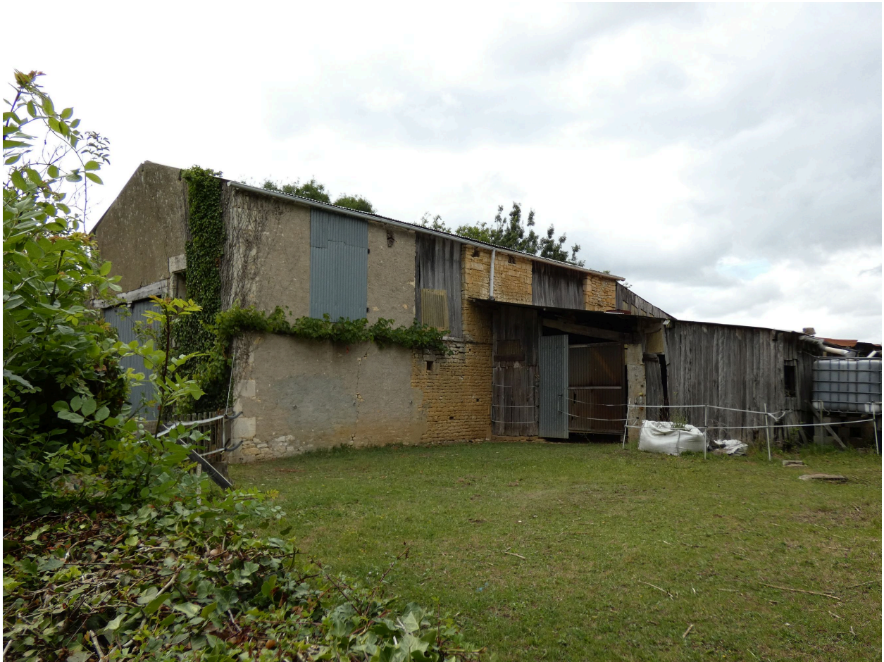
La grange-étable à façade en pignon vue depuis le sud-est.
