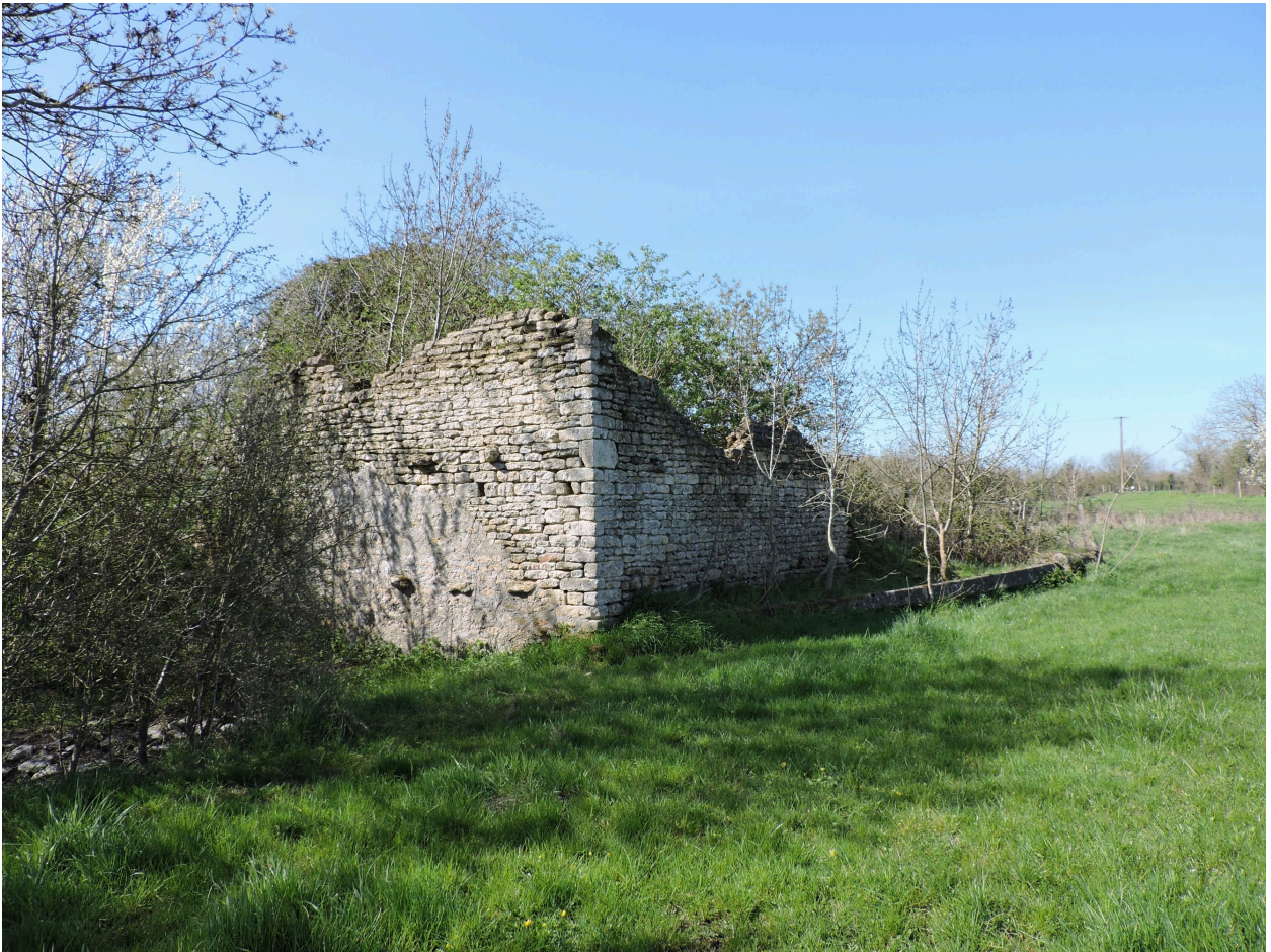
Les ruines de la dépendance accolée à l'arrière de la maison, vues depuis le nord-est.
