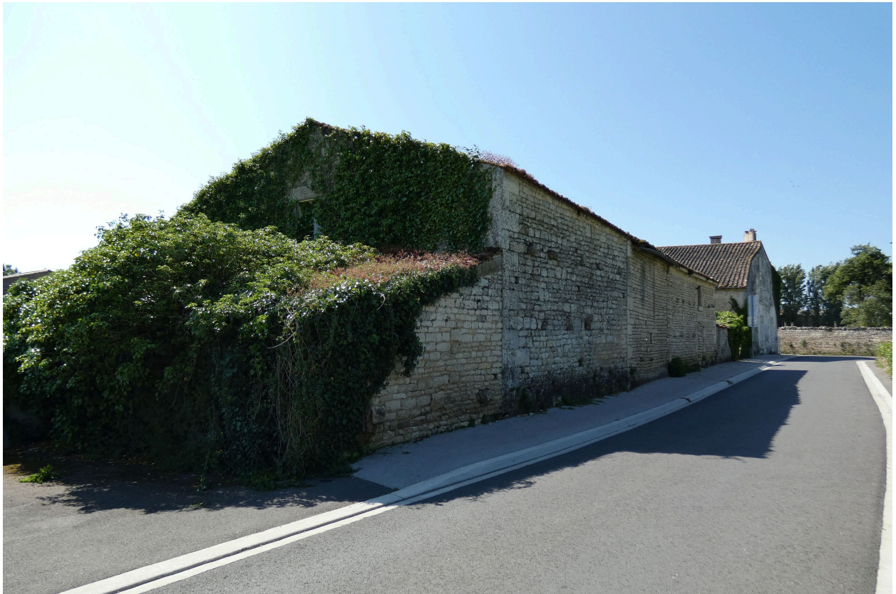
La grange-étable vue depuis le nord.
