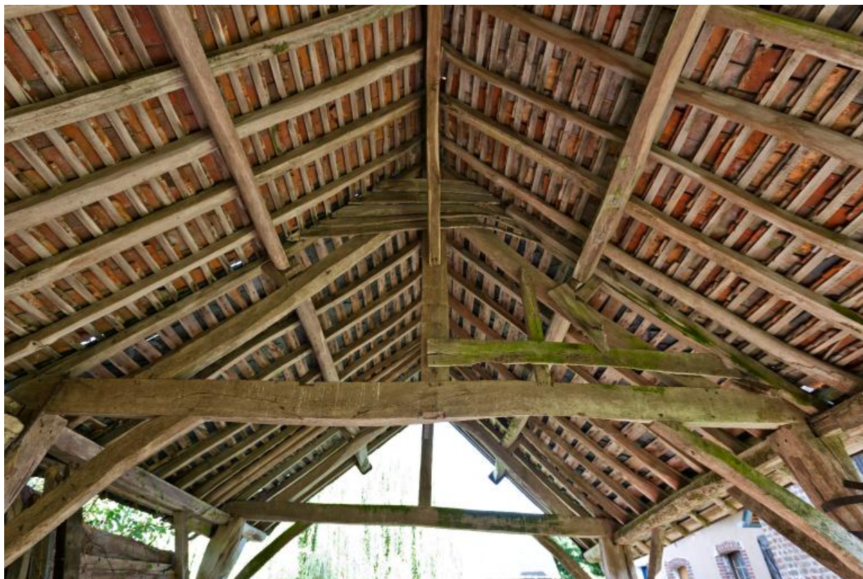
Hangar : la charpente.
