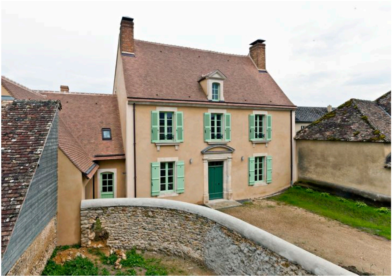
6, rue de la Poste. Élévation antérieure de la maison.
