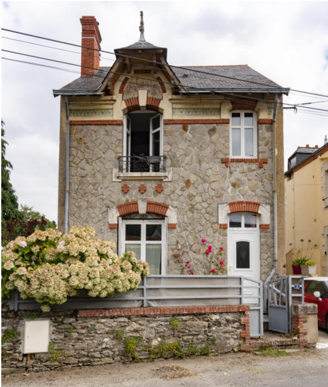
Maison, 1 rue de la Plage. Vue générale de la façade postérieure.
