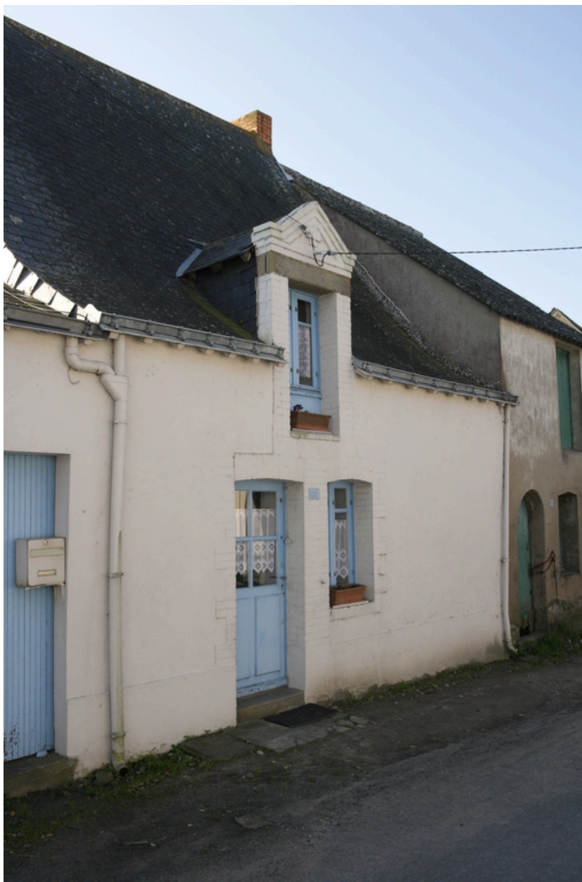
Vue du n° 25 rue du Rocher.
