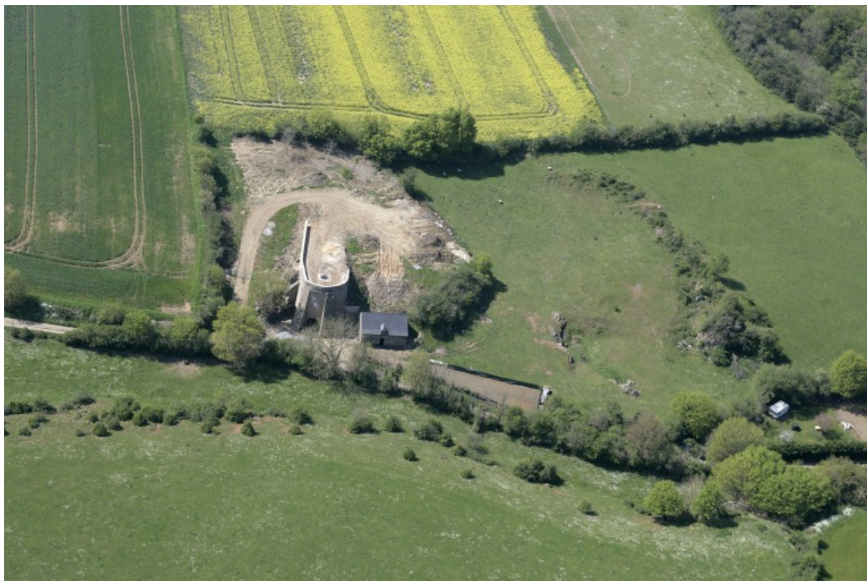
Vue aérienne d'ensemble depuis l'est. A droite, l'ancienne carrière.
