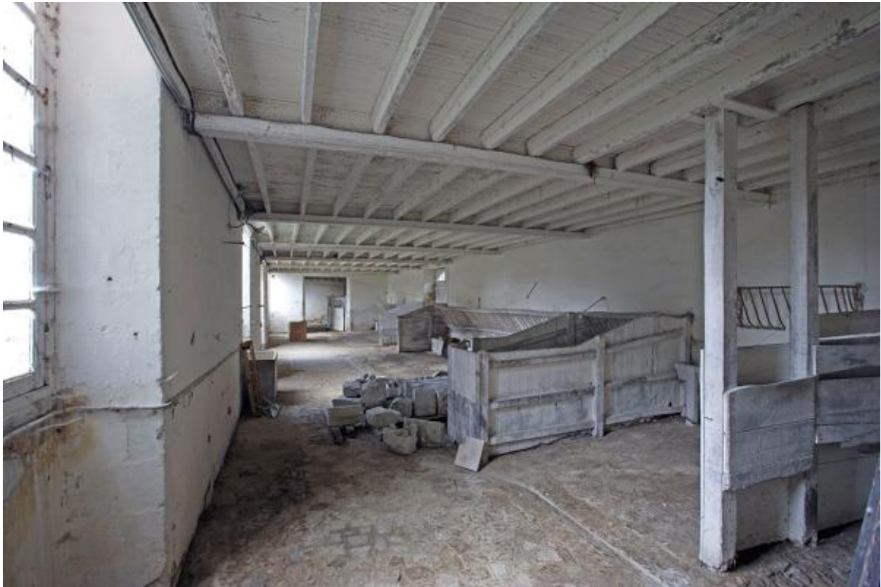
L'aile de communs nord, intérieur de l'écurie.
