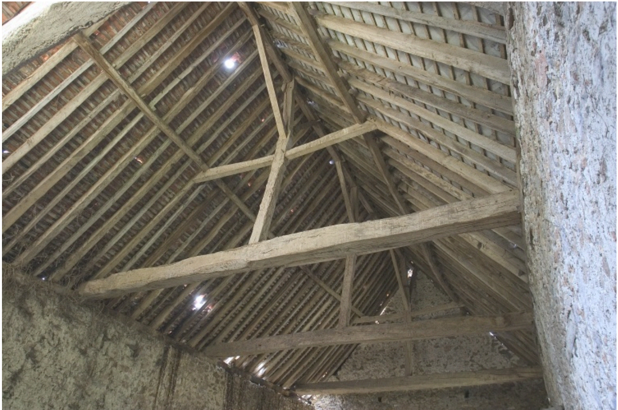
Intérieur de la grande étable : la charpente.
