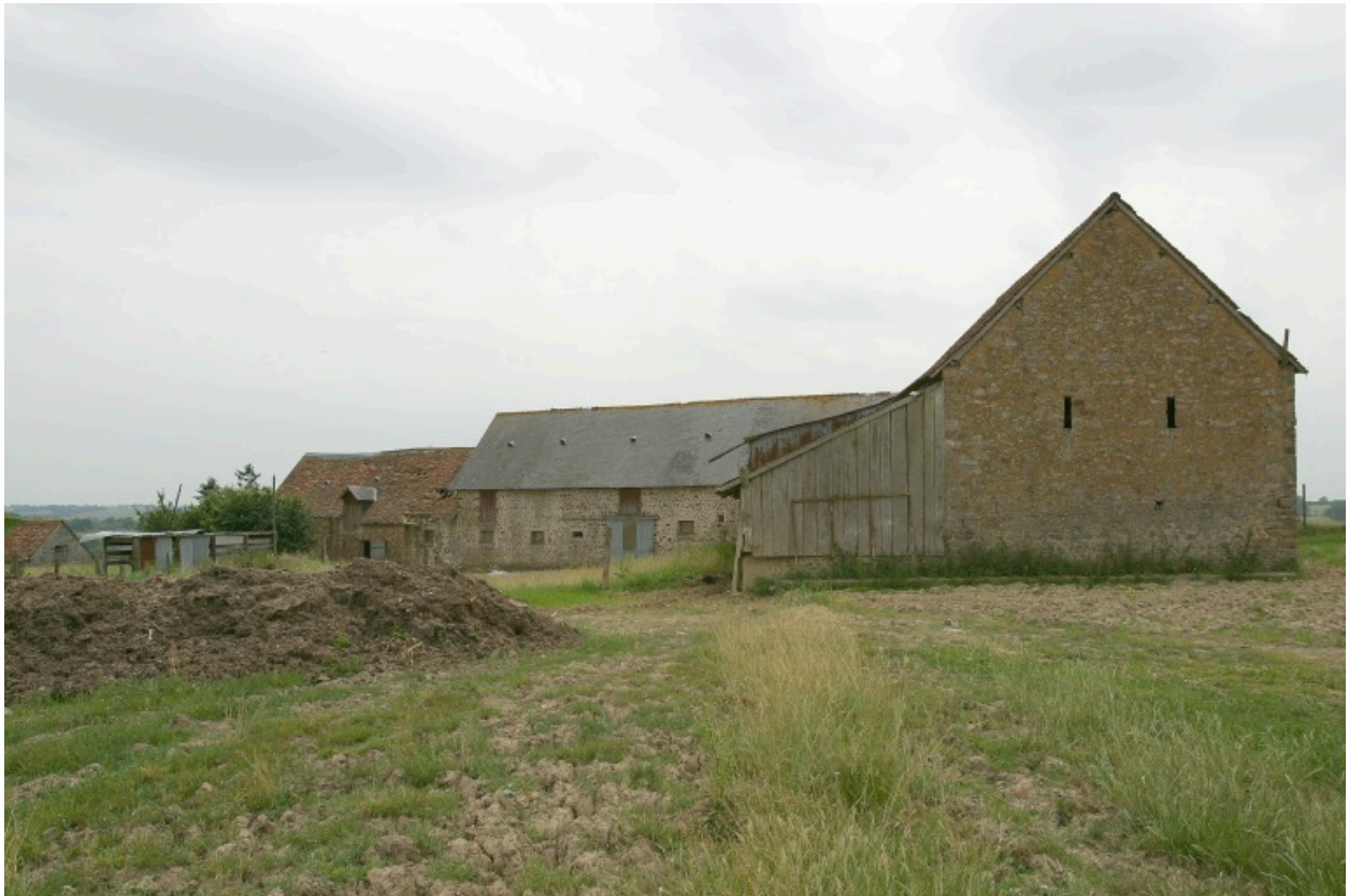
La porcherie, l'étable-grange et la remise vus depuis le nord.
