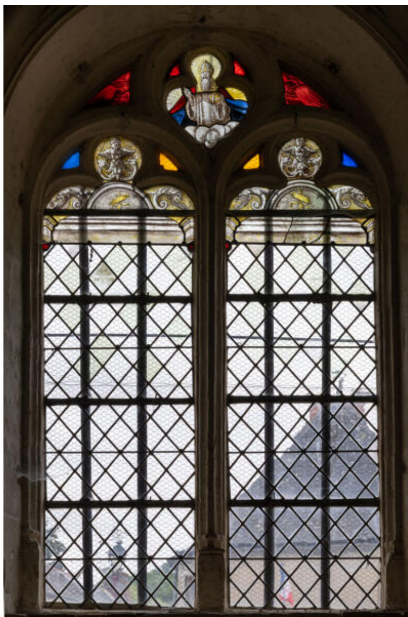
Fenêtre de la chapelle latérale, côté est : parties restantes d'une verrière.
