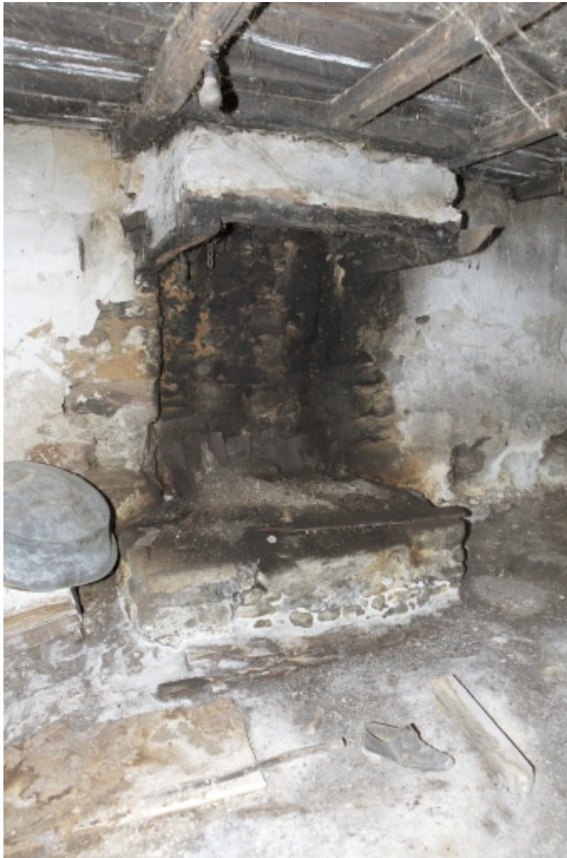
Ancien logis du meunier, intérieur de la salle, mur ouest ; détail de la cheminée.
