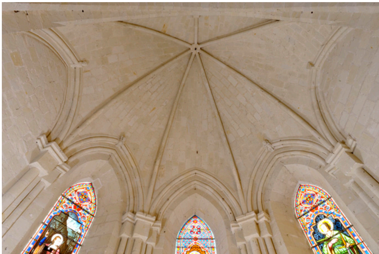
Voûte d'ogives du chœur.
