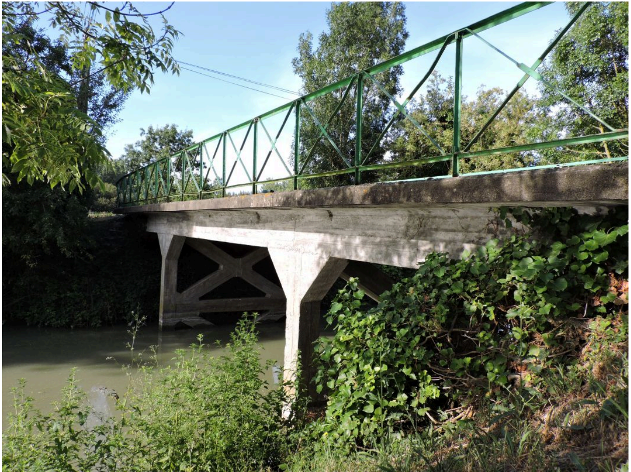
Le pont central vu côté amont depuis le nord-est.
