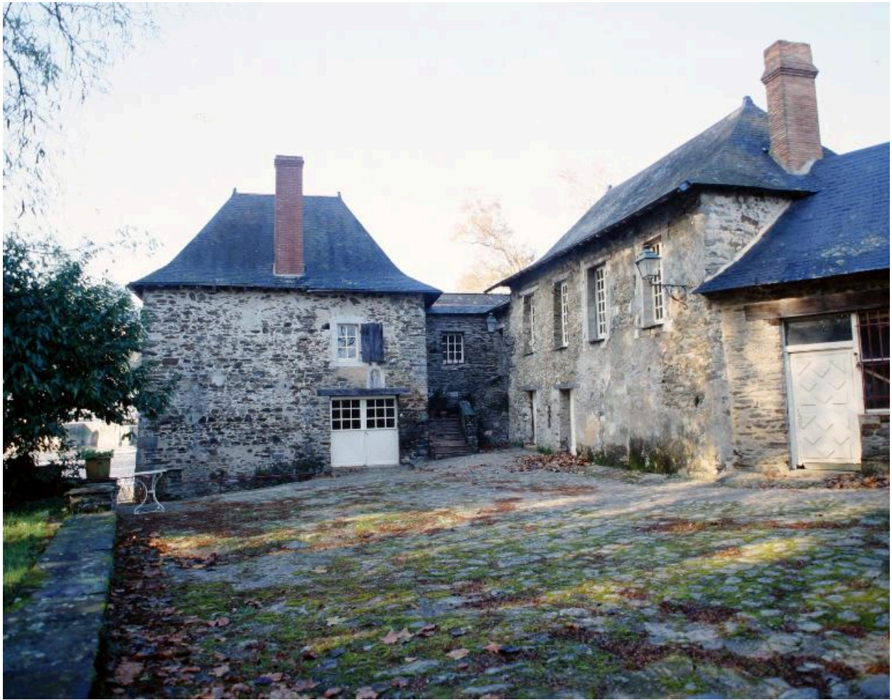
Le moulin et le logis vus de la cour à l'est.
