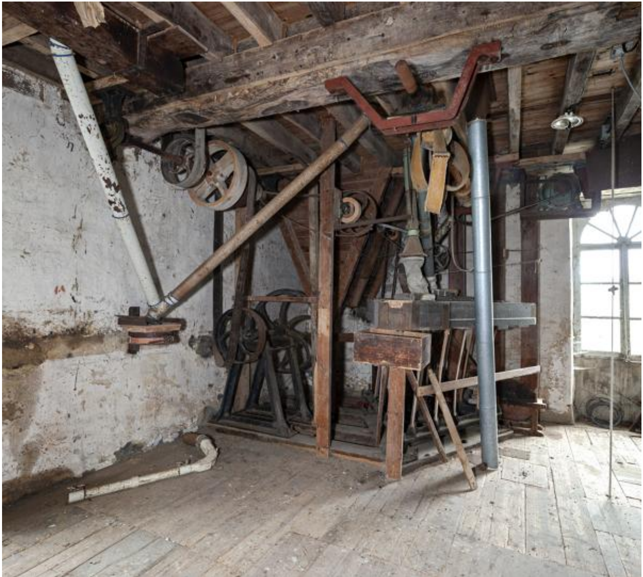
Premier étage, partie sud-est vue depuis le nord : l'épierreur et, au fond, la chambre à blé sale.
