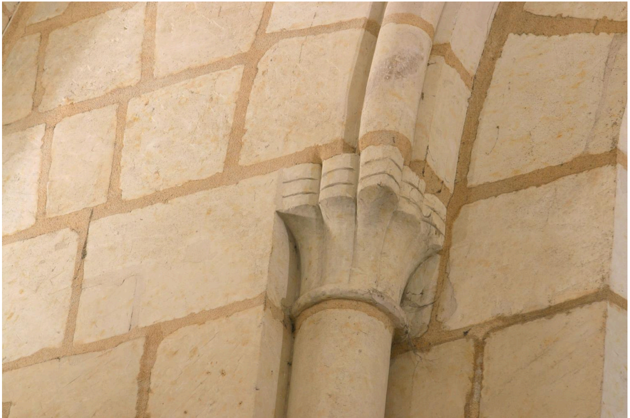
Chapelle Saint-Eloi, deuxième travée : baie sud, chapiteau de la colonnette est (gauche).
