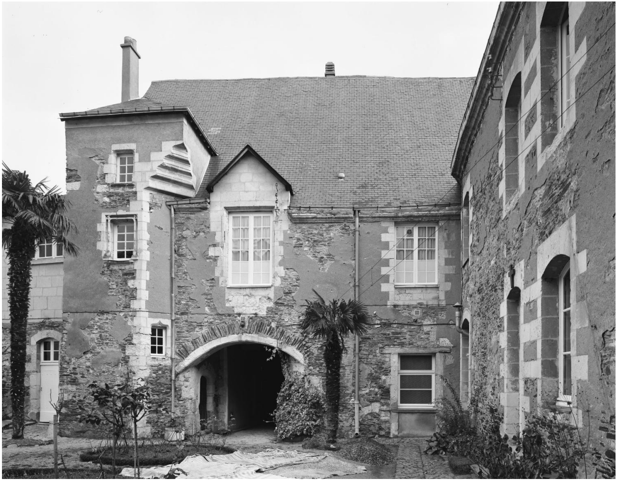
Logis de Puygaillard : façade cour.
