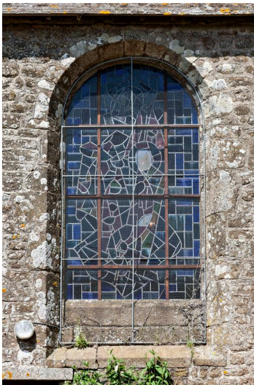
Chapelle sud-est : fenêtre.
