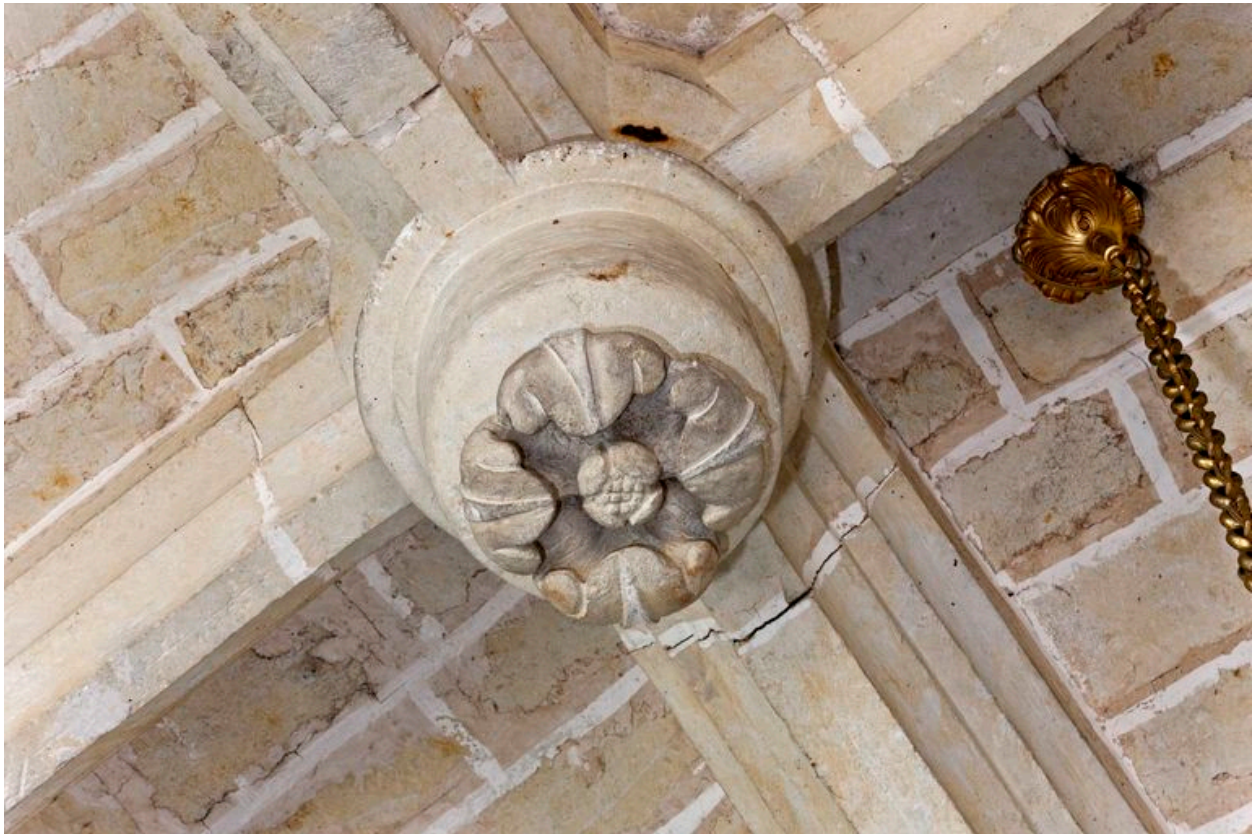
Clé de l'arc doubleau séparant les deux travées.
