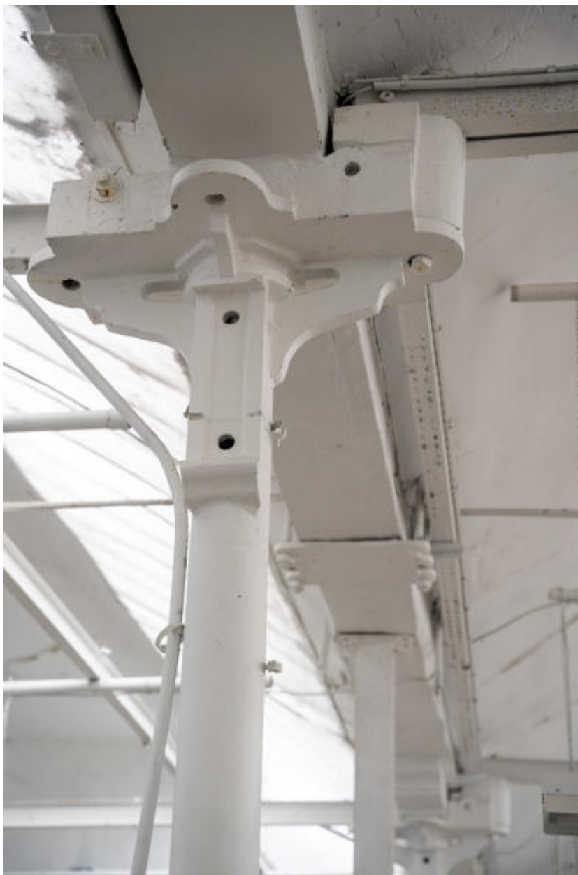
Détail d'une colonne de fonte portant la charpente de l'atelier de fabrication A.
