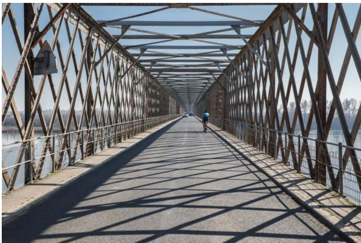
Vue du tablier et de la cage.
