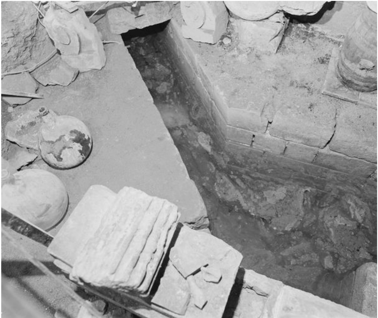
Sous-sol, système hydraulique, détail des canalisations.
