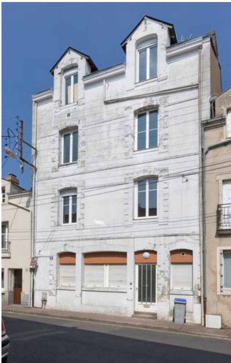
Immeuble, 6, rue de Tréméac.
