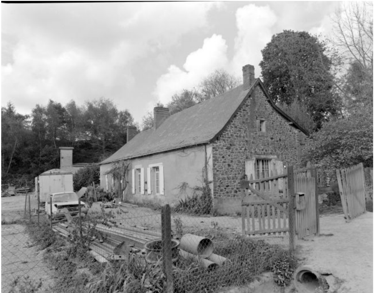
L'ancienne maison de meunier.
