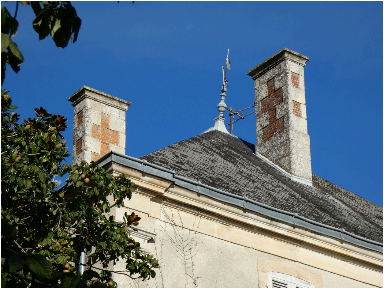
Détail du toit : croupe, épi, souches de cheminées et corniche.
