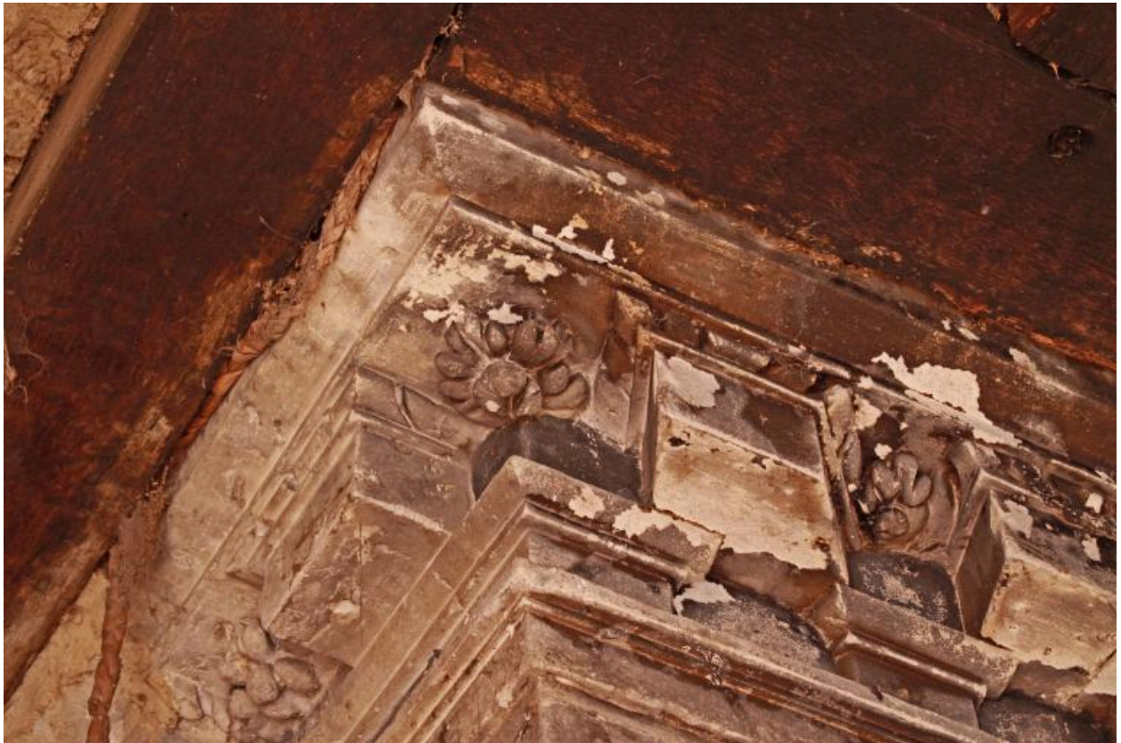
Pavillon, étage, cheminée : détail angle gauche de la corniche.
