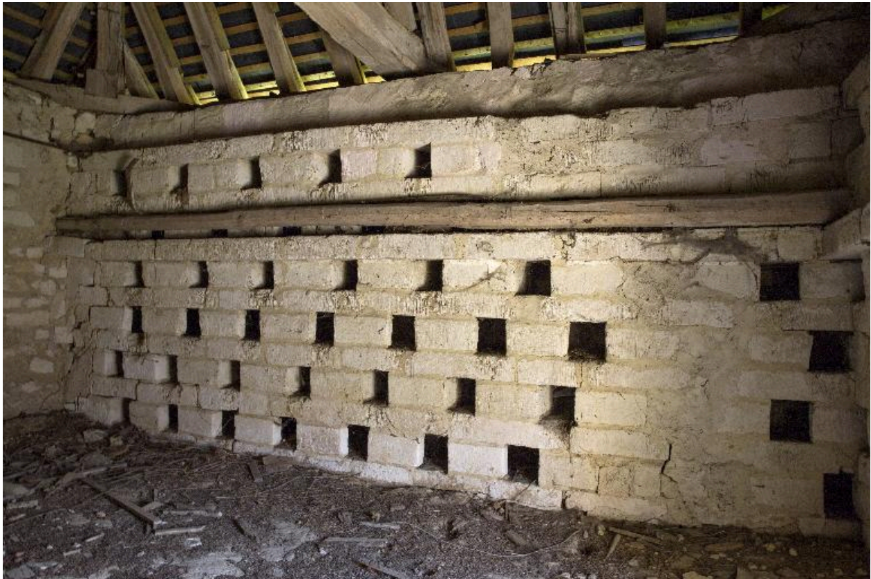
Le pigeonnier : détail de la mise en oeuvre des trous de boulins à l'étage.
