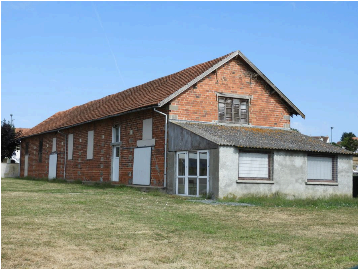
L'atelier de fabrication vu depuis l'est.
