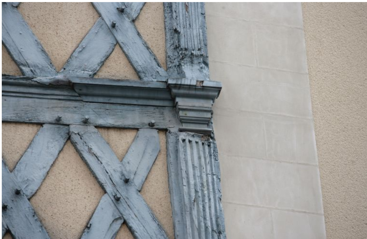
Façade sur rue, 2e niveau : pilastre cannelé et chapiteau dorique du poteau-cornier droit.
