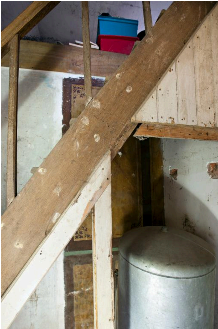
Maison, couloir central, mur est : peinture murale.
