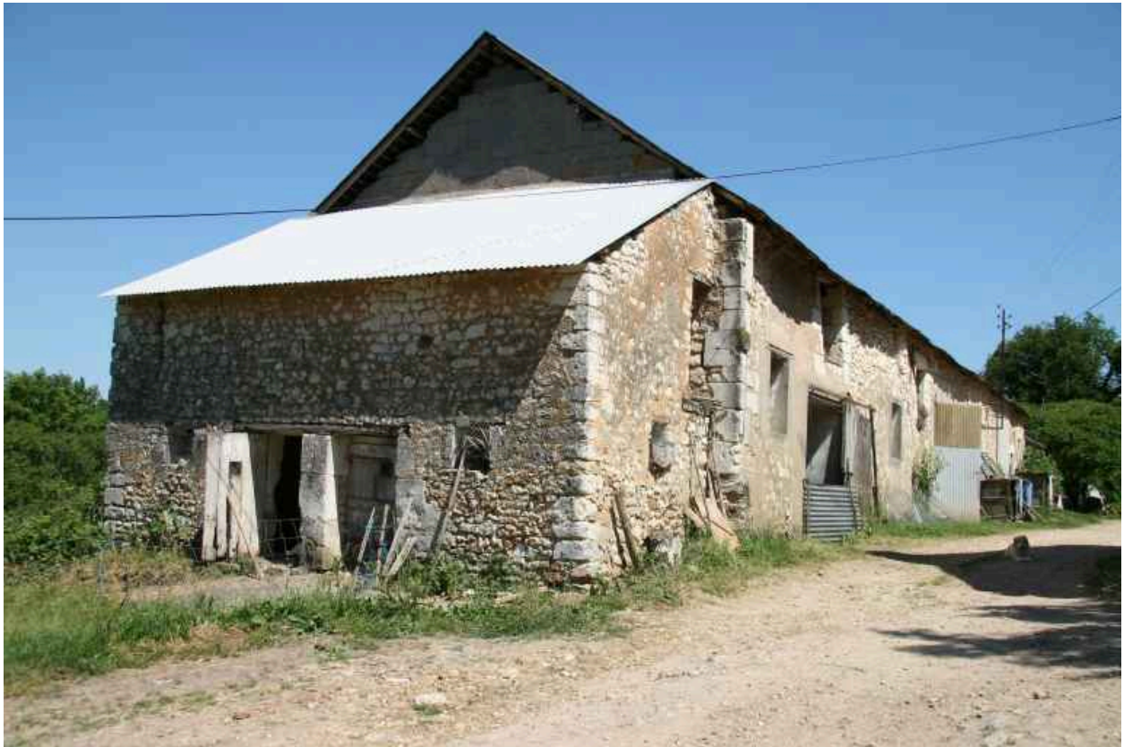
Vue d'ensemble prise de l'entrée de la cour.
